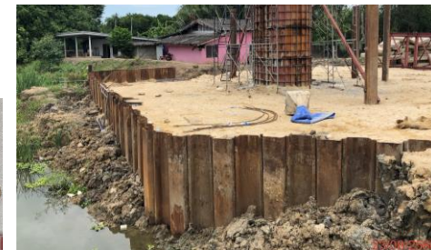
ติดตั้ง Sheet Pile ริมตลิ่งน้ำ
